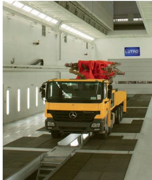
Großraumlackieranlage für die Nutzfahrzeuglackierung/ Large-capacity spray booths for vehicle manufacturing
